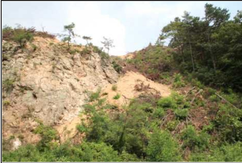
【그림 3】 깎기비탈면 시점부 측면 사진
