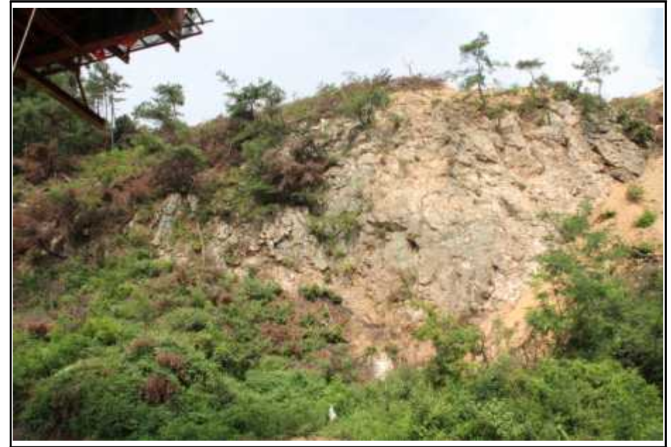
【그림 4】 깎기비탈면 종점부 측면 사진
