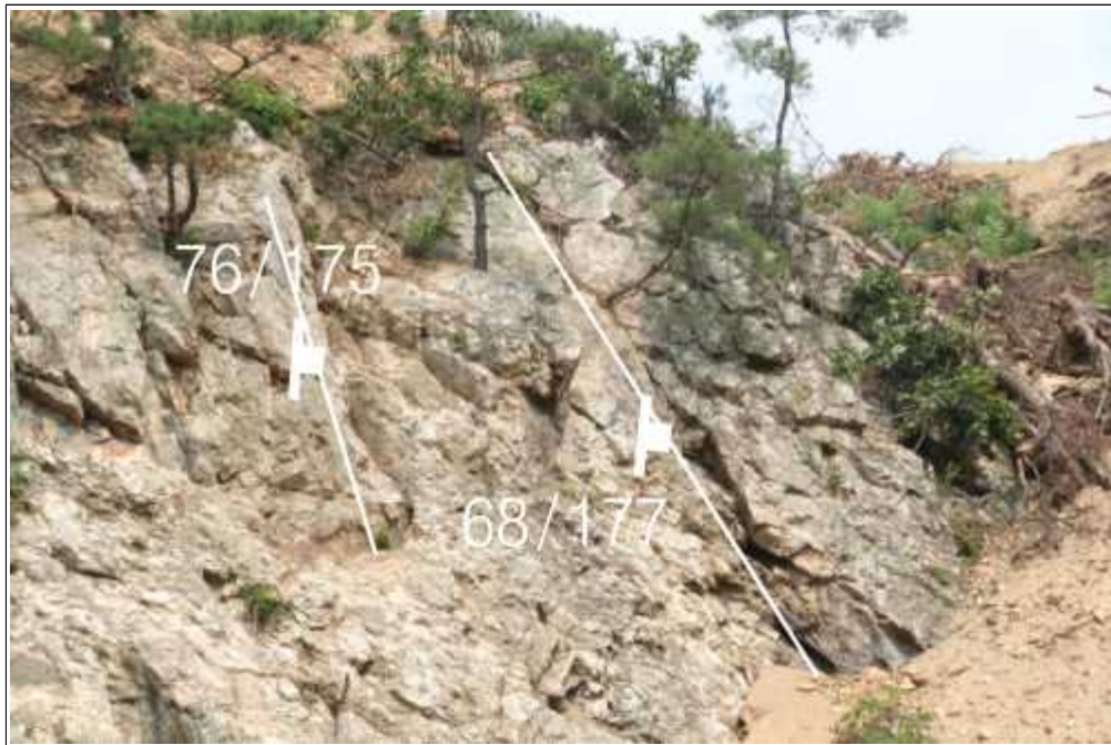
【그림 18】 B 영역에 발달한 불연속면
