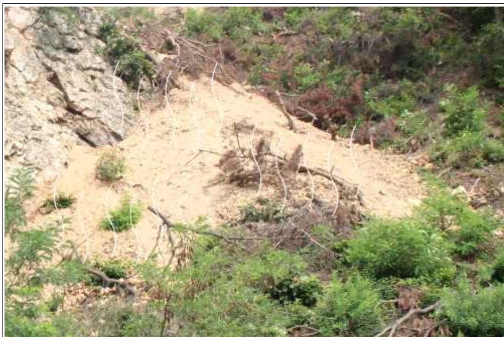
【그림 19】 B 영역 상세사진 (토사유실)
